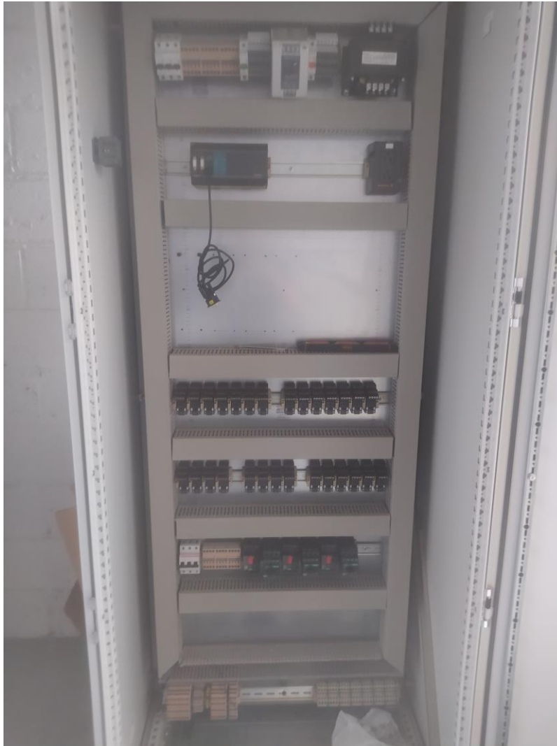
Fig. 49 Colocación de dispositivos.
