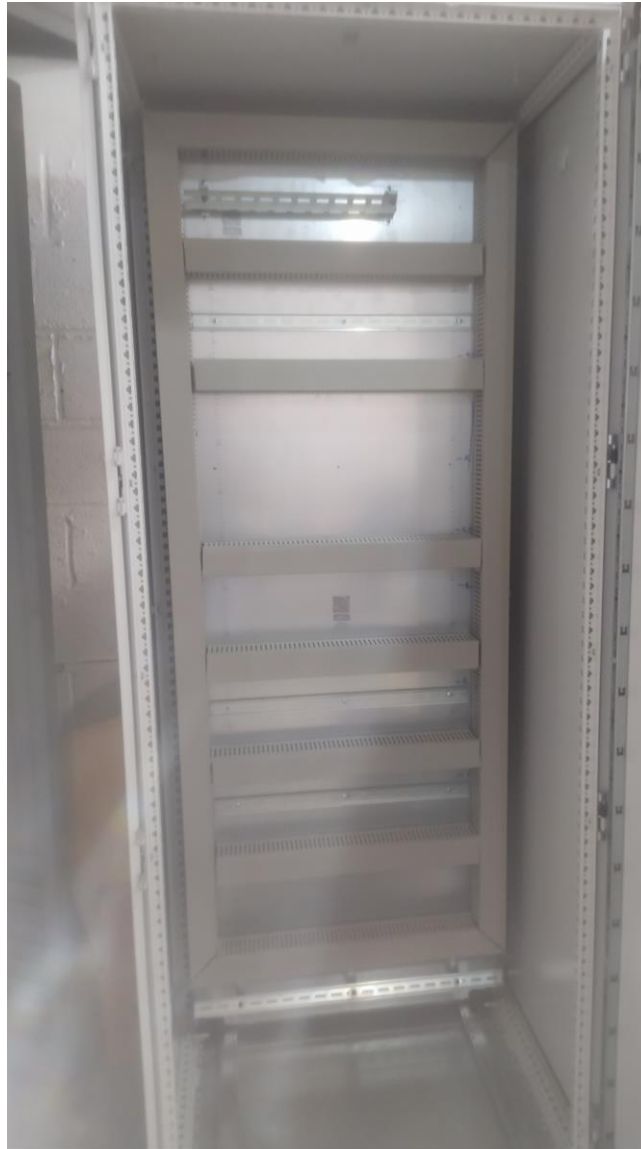
Fig. 42 Gabinete con canaleta y riel instalado.
