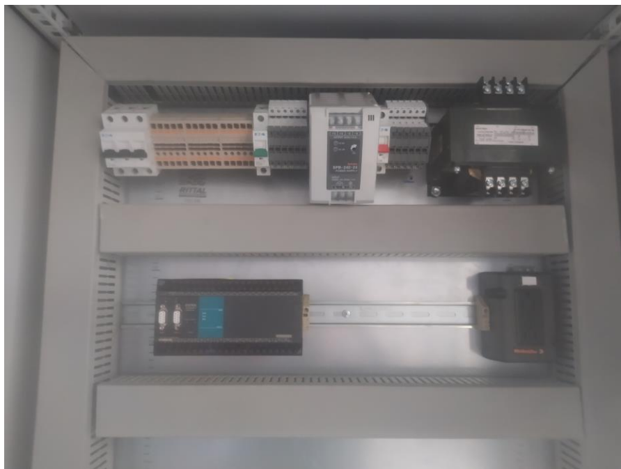
Fig. 46 Colocación de componentes de renglón 1 y 2.
