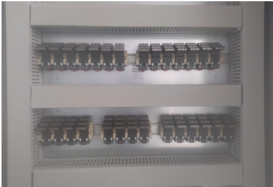
Fig. 47 Colocación de bases para relevadores en renglón 4 y 5
