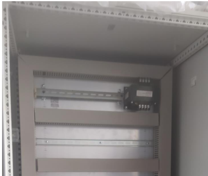
Fig. 45 Fijación de transformador hacia platina de gabinete
