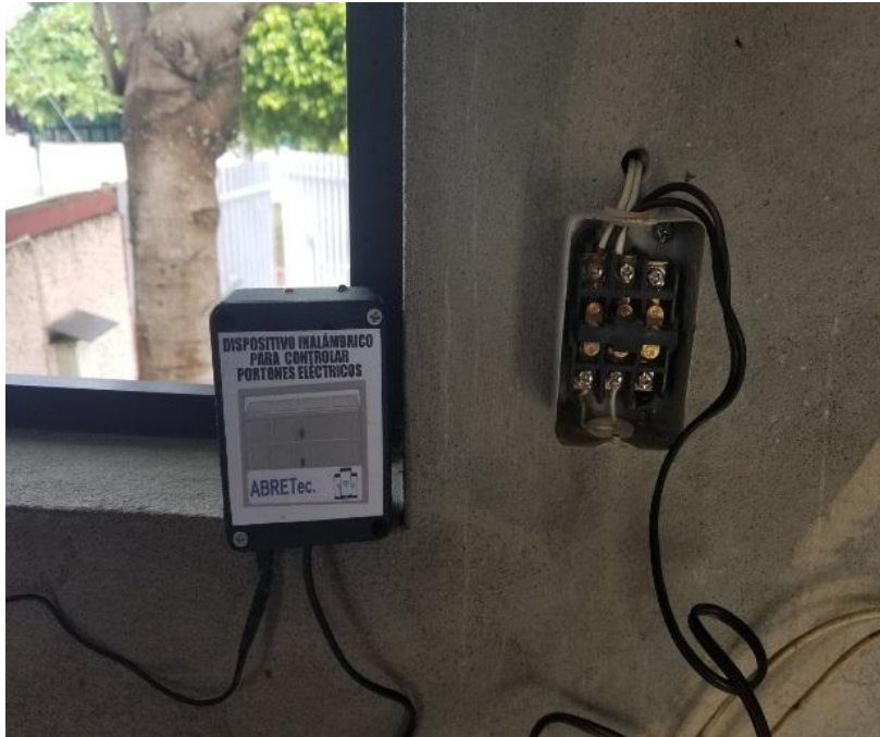
Figura 30. Instalación del dispositivo.
