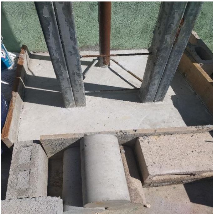
Figura 24. Cimentación de hormigón de 80x80 cm
