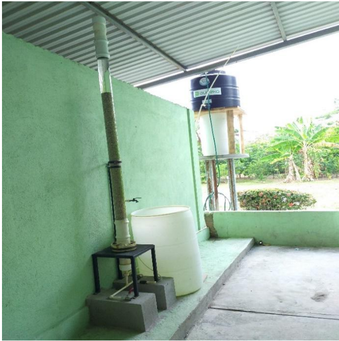
Figura 27. Instalación final del reactor
