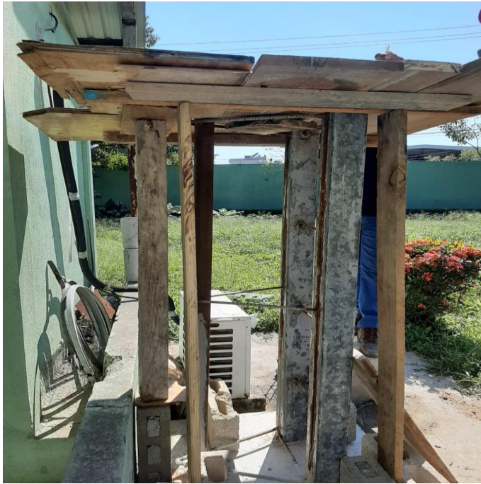
Figura 25. Construcción de un colado extra en la parte superior de la malla electrosoldada
