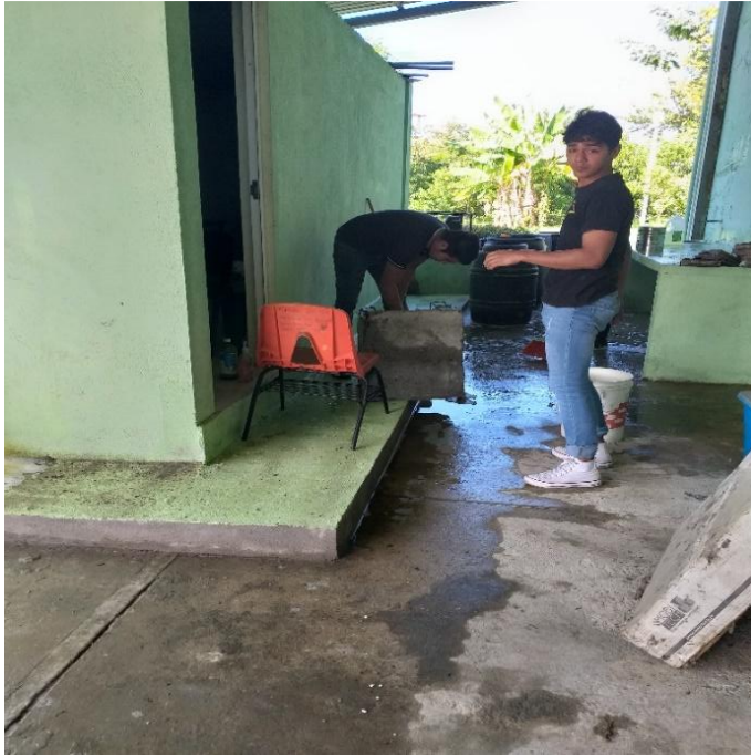
Figura 21. Sitio de instalación del reactor
