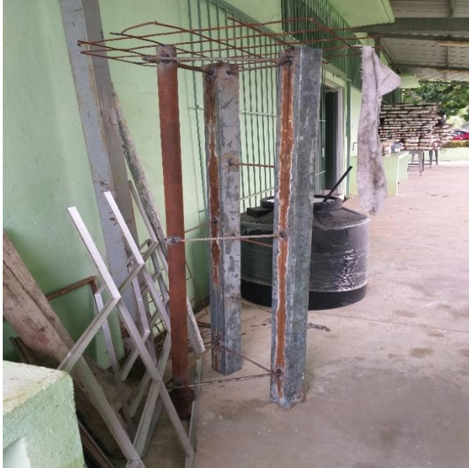
Figura 23. Malla electrosoldada con base triangular de perfiles de acero
