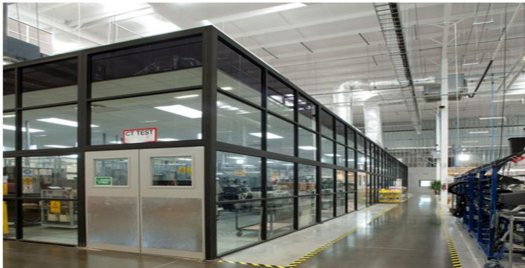
Figura 31 - Departamento de Pruebas Eléctricas.
