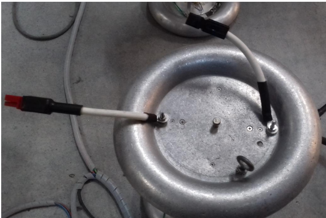
Figura 70 - HVD con Conectores Anderson.
