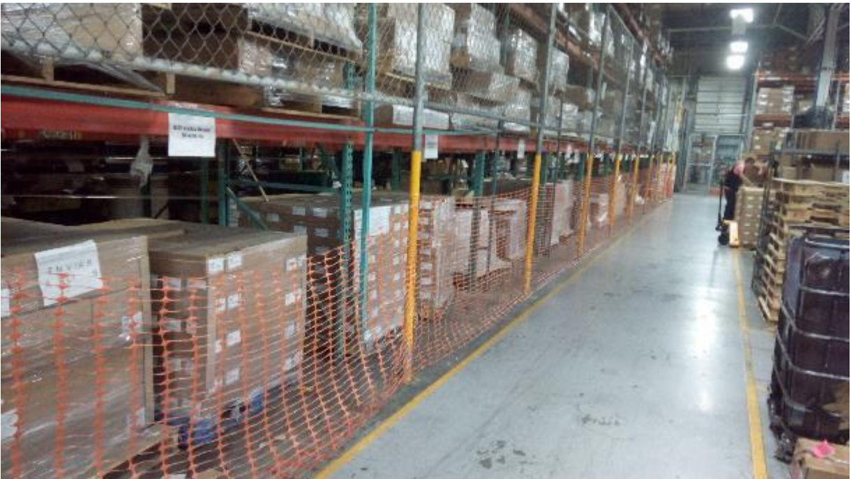
Figura 32. Valla de seguridad provisional en almacén
