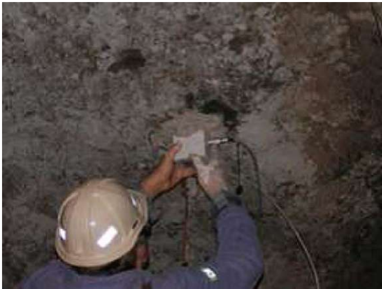
Fig. 5. Colocación de acelerómetro en el techo de una mina.
