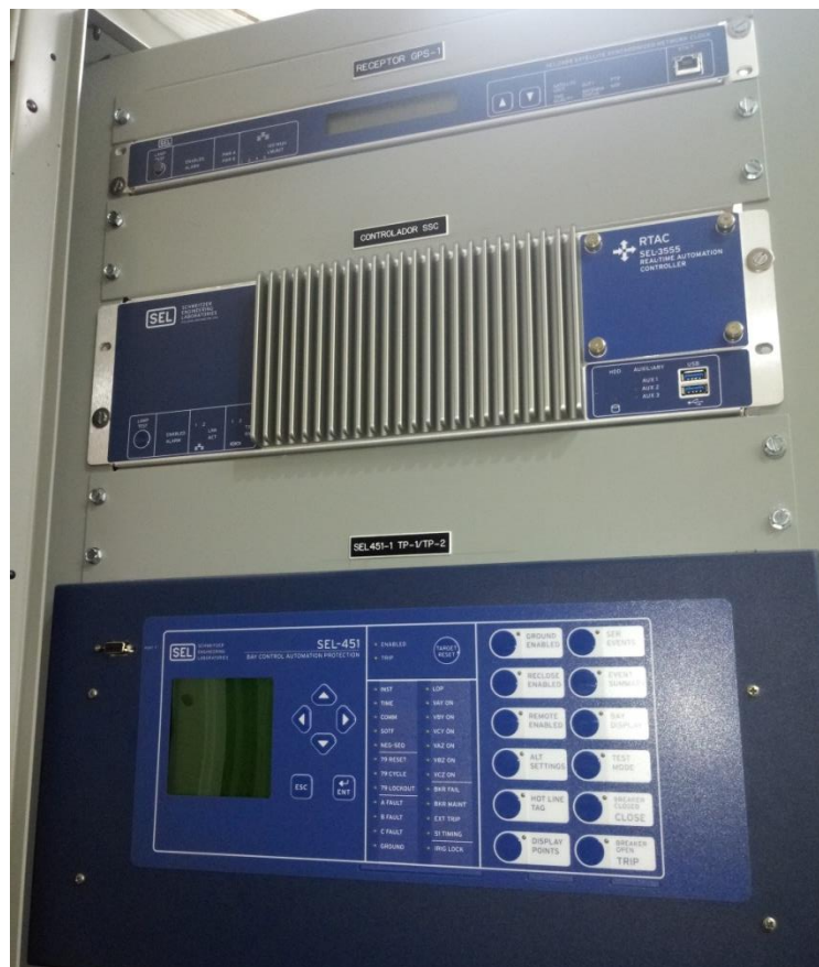
Figura 4. 13.- Relevador 1, RTAC y receptor satelital GPS
