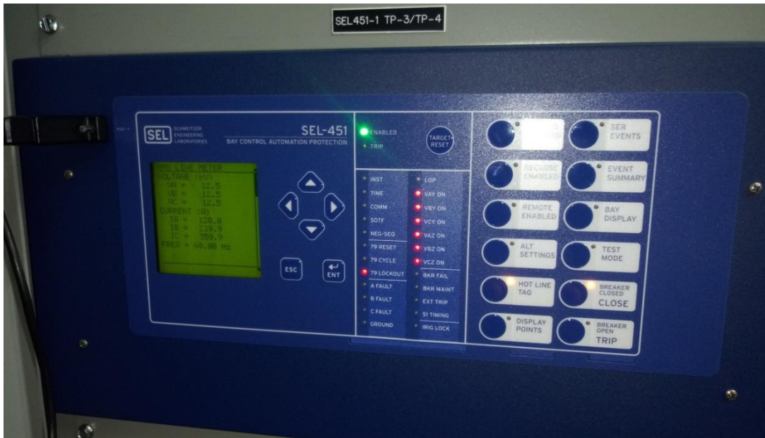
Figura 4. 12.- Pruebas a relevador de la Bahía de MTG2
