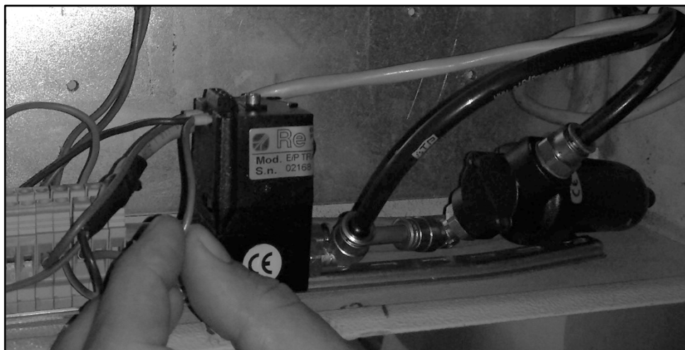
Figura 4.7 Instalación de Servo válvula.
