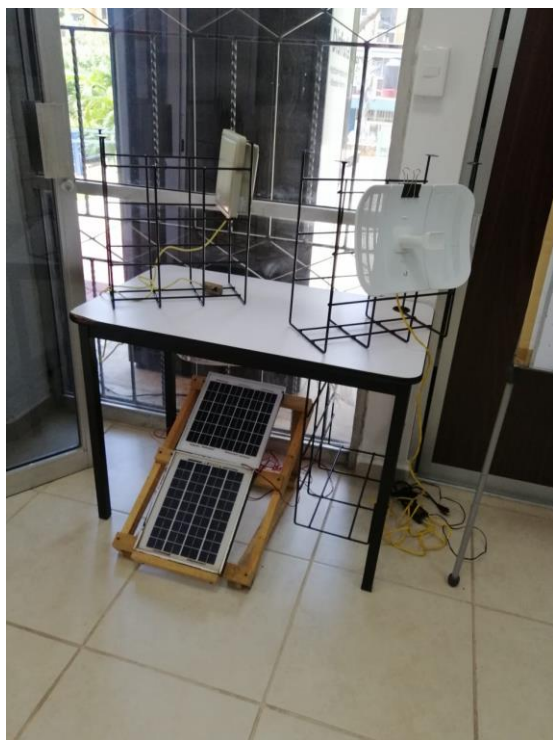
Figura 4.30 Antenas Cerro 1 y Cerro 2 alimentadas por los paneles solares
