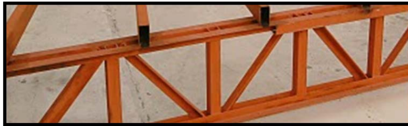
Figura 3. 33 Ejemplo de perfiles de hierro existentes
