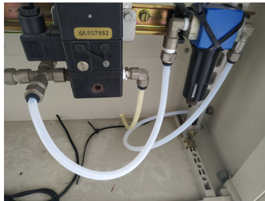
Fig. C.2.1. Reconexiones neumáticas
