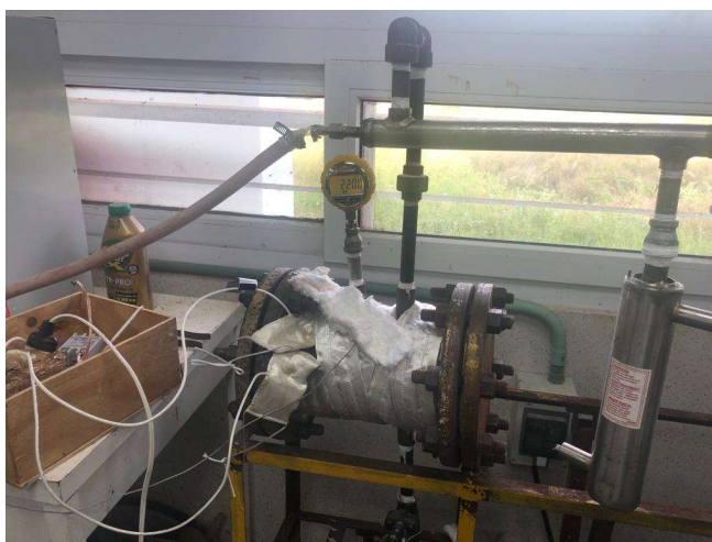
Figura 8 Evaporador final de polimerización operando a condiciones establecidas.
