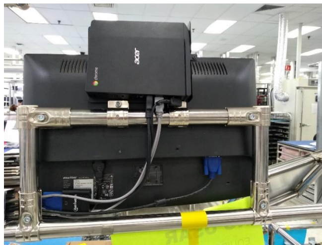
Figura 25. Orden de cableado (ruteo). Fuente área de IT Soporte de equipo de cómputo.
