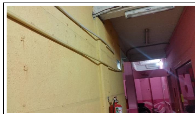
Figura 133. Canaletas en los pasillos.
