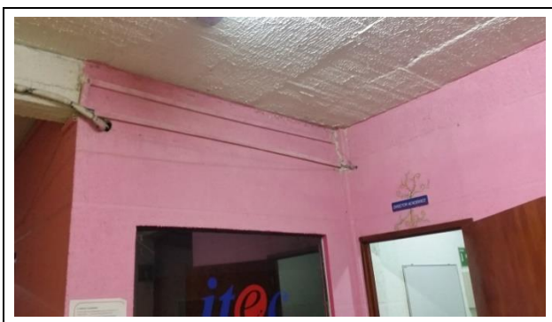
Figura 132. Canaletas en los pasillos.
