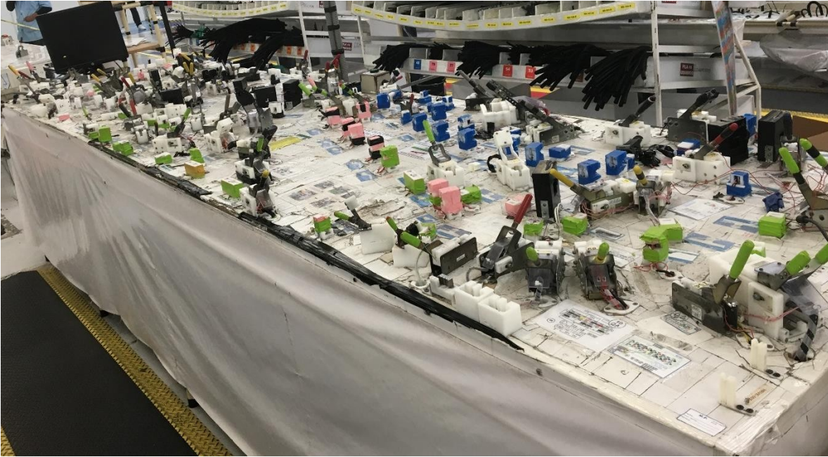
Imagen 53 Muestra del estado del tablero de prueba eléctrica antecesor a la construcción del tablero actual, vista lateral derecha. Foto por Eduardo Trujillo.
