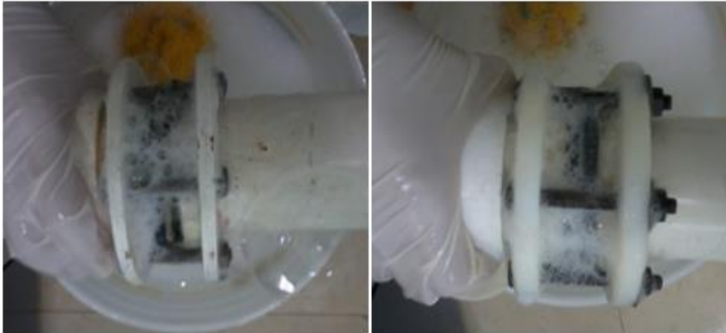
Figura A.2 Pruebas de hermeticidad a) con fuga, b) sin fuga
