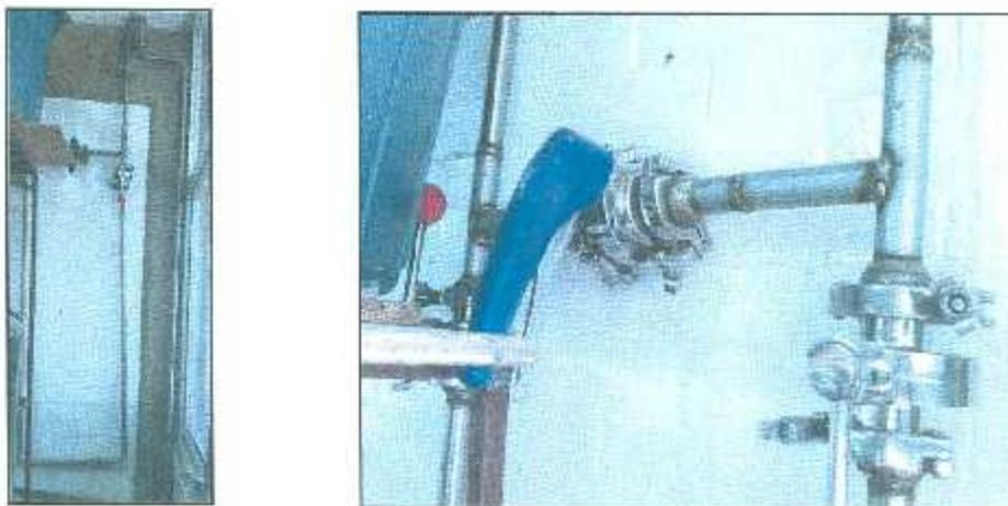
*Figura 3.20. Bajada de tubería de agua destilada y purga, y bypass de en la línea de agua destilada para la habilitación o deshabilitación de U barométrica.*
