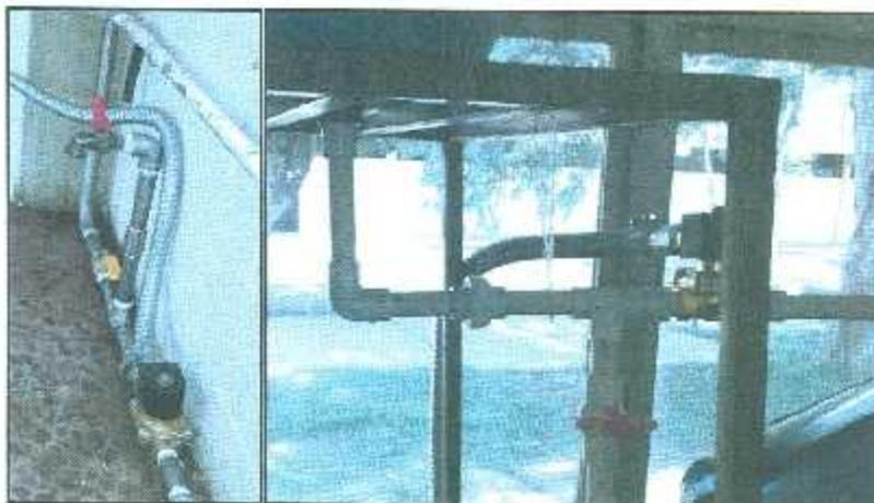
*Figura 3.35. A. (Izquierda) Válvula solenoide en línea de purga de charola. B (Derecha) Válvula solenoide instalada en tubería que une tanque de almacenamiento diario con tanque general.*
