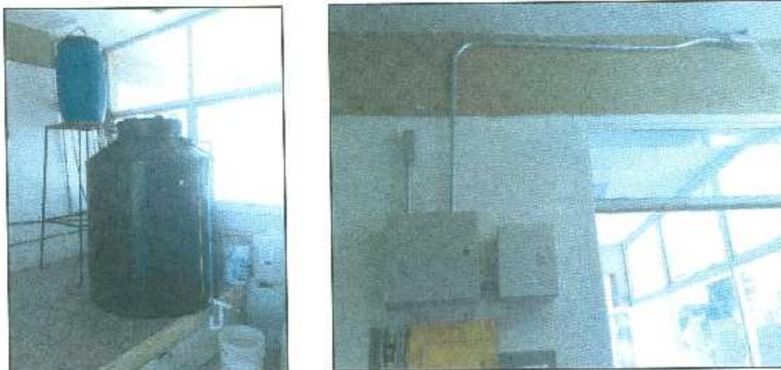
*Figura 4.2. Tanques de almacenamiento de agua destilada y tableros de control.*
