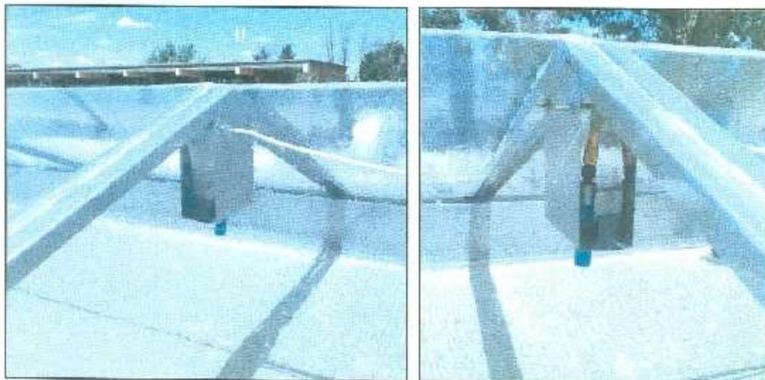
*Figura 3 27. Montaje de base y sensor de nivel de agua en charola.*
