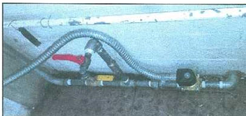
*Figura 3.21. Instalación de válvula solenoide en línea de purga.*
