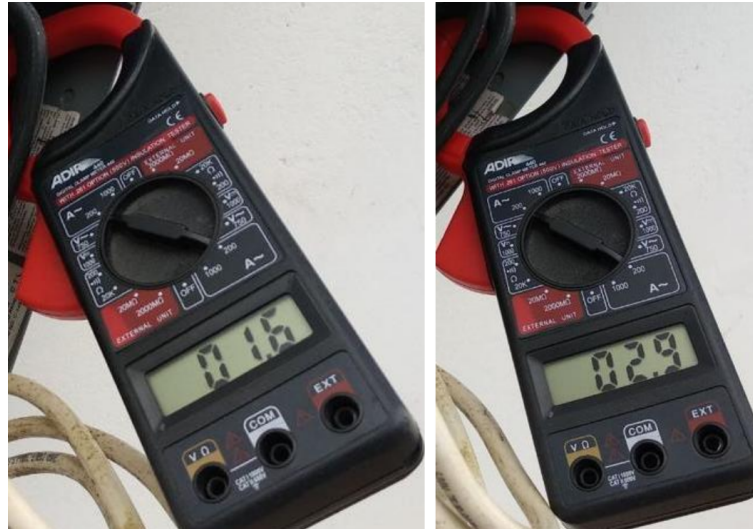
Figura 4.7: Comprobación de Consumo con Amperímetro de Gancho Radio Club S.A de C.V Ubicación Gonzáles Ortega
