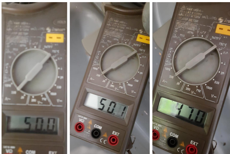
Figura 4.2: Comprobación de Consumo con Amperímetro de Gancho XHTU F.M S.A De C.V Ubicación Carretera México-Tuxpan
