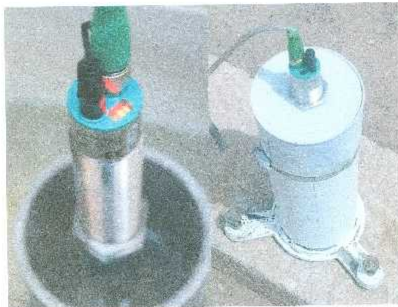
Figura 26. Montaje del sensor
