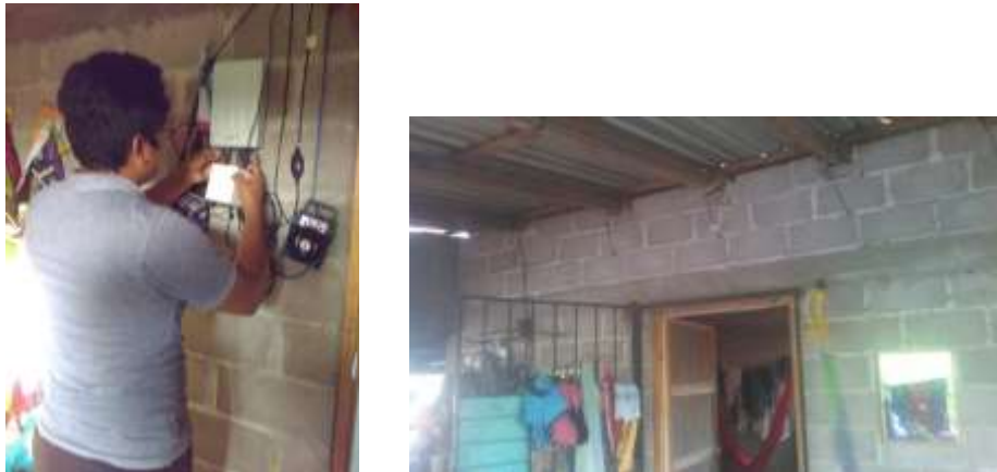
Figura 46. Instalación del Sistema inteligente.
