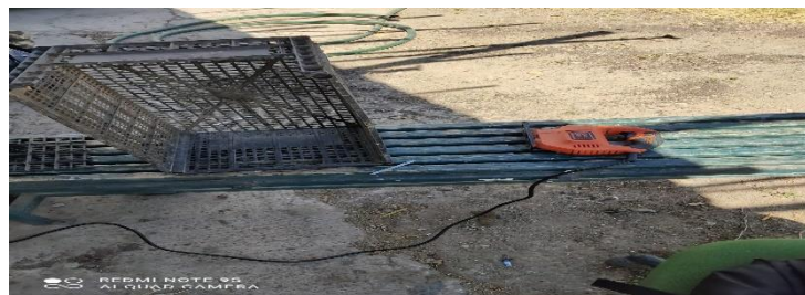
Figura 13. Perforación de las cajas con segueta
