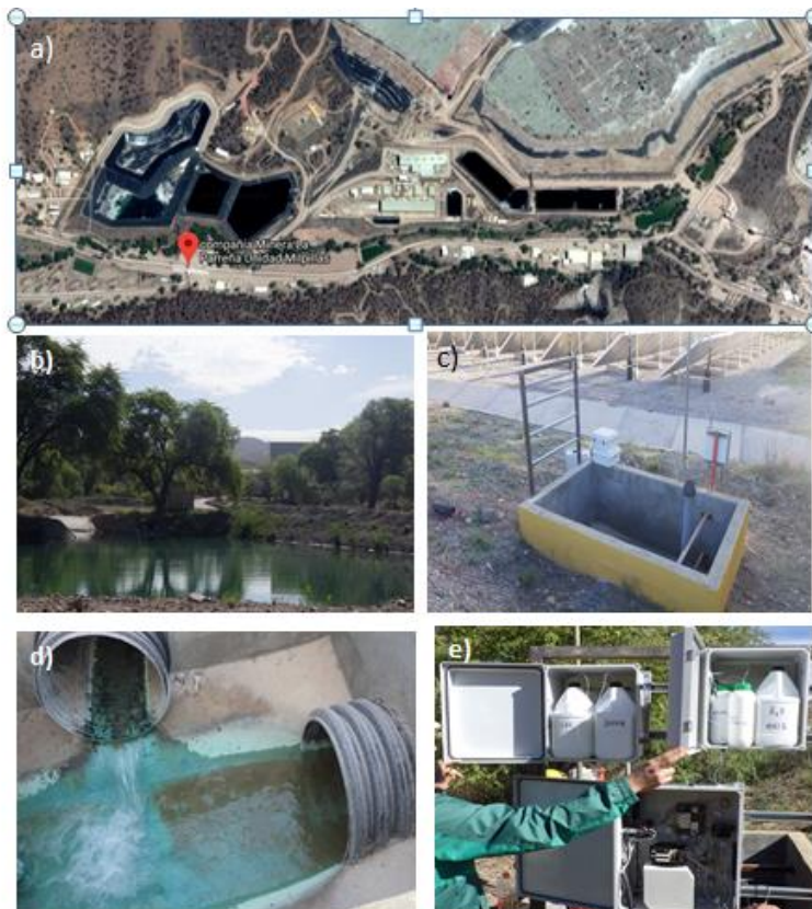
Figura 4.47 a) Localización del MFIACu V1 en la Mina La Parreña, unidad Milpillás. b) Represa 5. c) Colector de salidas de agua de mina del Represa 5 d) Salidas de agua de mina del Represa 5 e) Gabinetes Industriales del MFIACu
