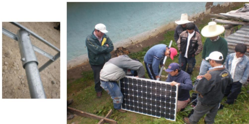
Figura 52. Montaje Panel Fotovoltaico
