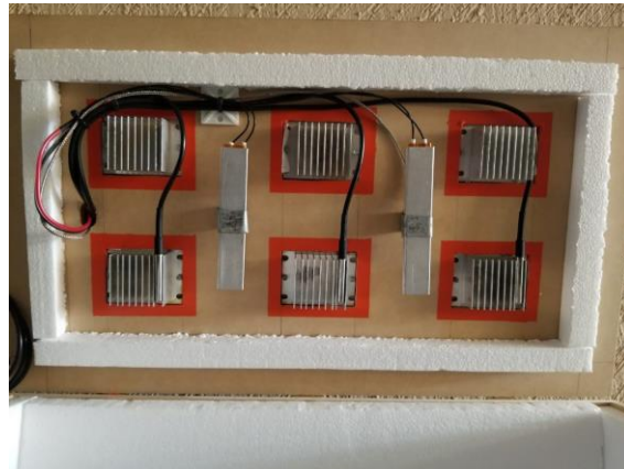
Figura 47. Montaje de Resistencias Calefactoras
