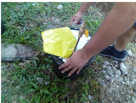
Figura 15. Sellado de los biodigestores.
