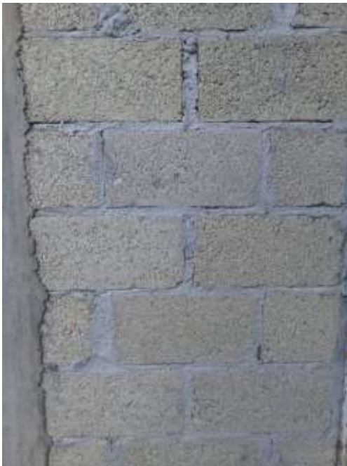
Figura 1.- Muro construido con block de tepezil. (Autor Propio, 2020)
