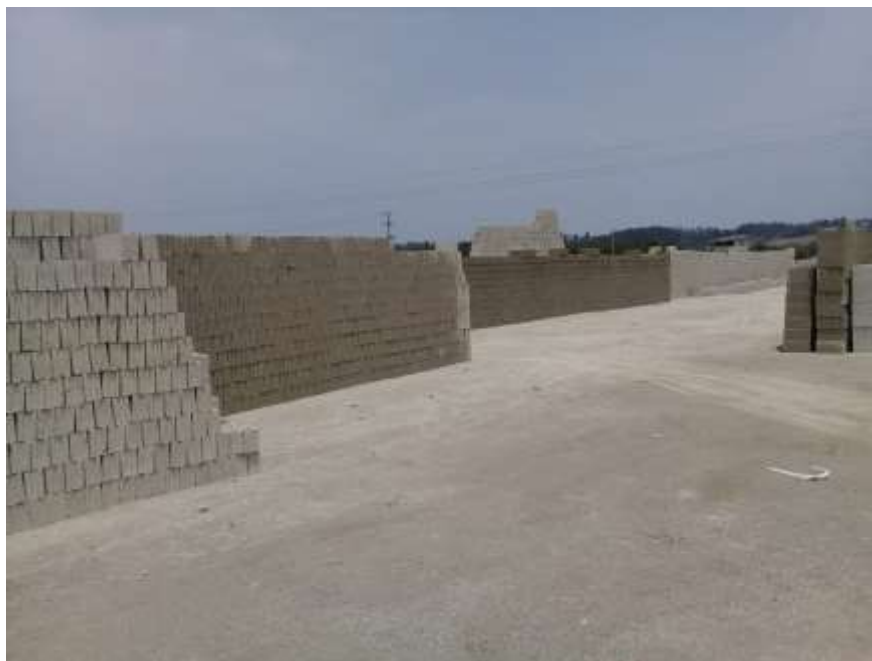
Figura 26.- Área de secado. (Autor Propio, 2019)
