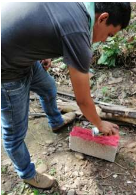
Figura 53.- Aplicación de pintura en aerosol al block de tepezil. (Autor Propio, 2021)
