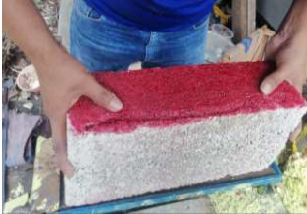
Figura 57.- Colocación del block. (Autor Propio, 2021)
