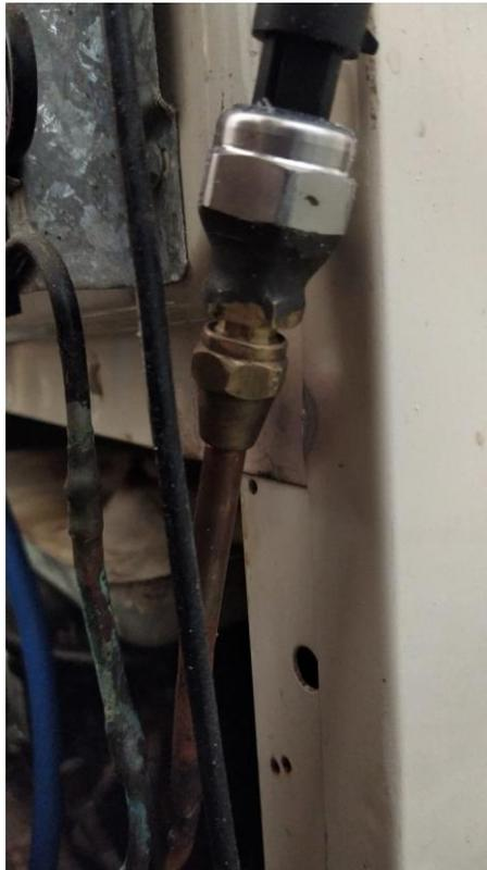
Figura 26. Sensor con fuga.
