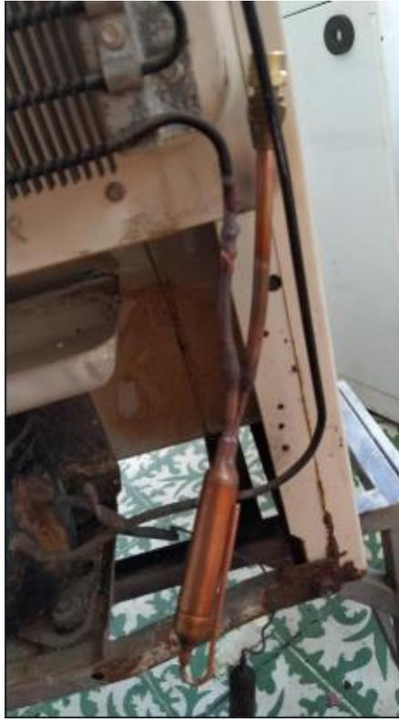
Figura 23. Sensor de presión soldado con tubo capilar.
