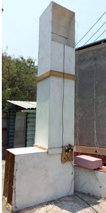
Fig. 3.6 Fotografía de la torre de viento con sistema de humidificación
