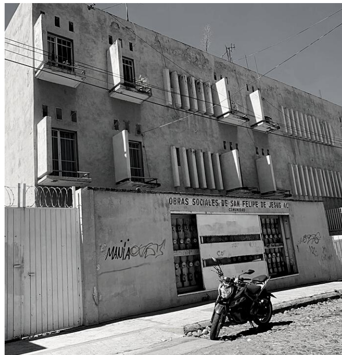
Figura 25.- Edificio ubicado en calle Motolinia Fuente: Elaboración propia.
