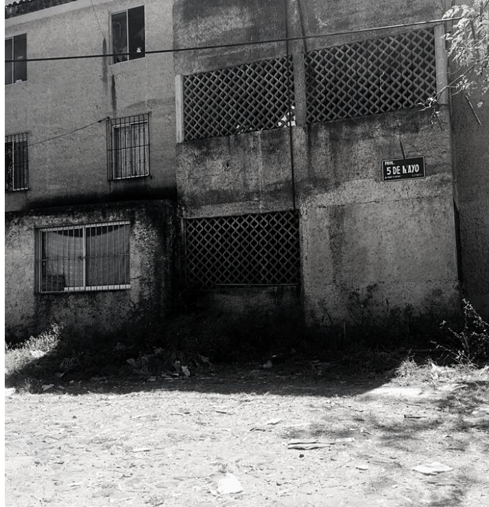
Figura 26.- Edificio en calle 5 de mayo Fuente: Elaboración propia
