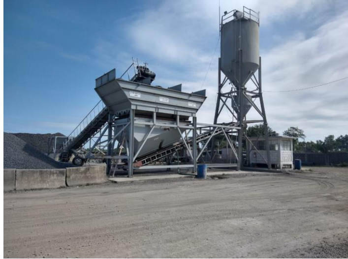
Figura 7 Concretera para la producción del concreto Hidráulico.
