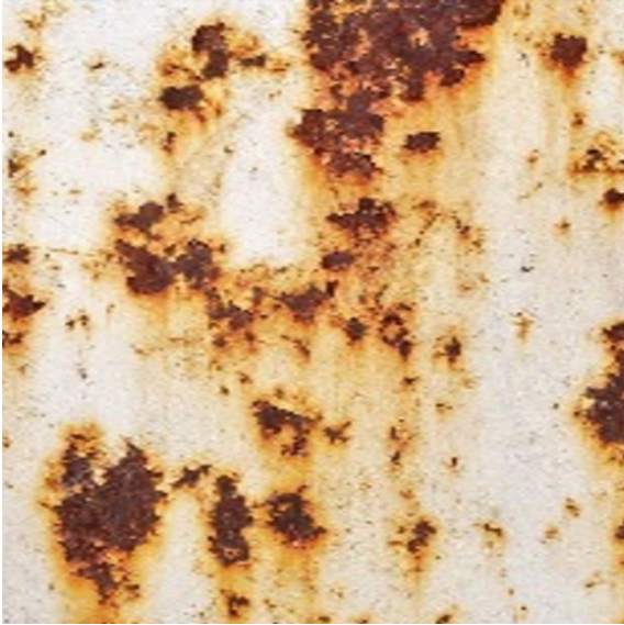
a) Fracción de una imagen obtenida de la web https://sp.depositphotos.com/6214202/stock-photo-rusted-and-corroded-surface.html
