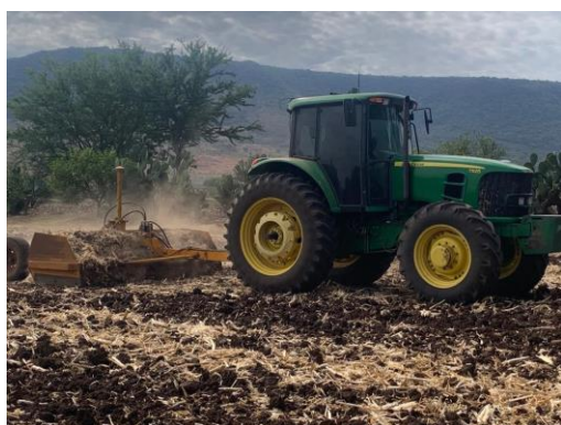
Nivelación de terreno
