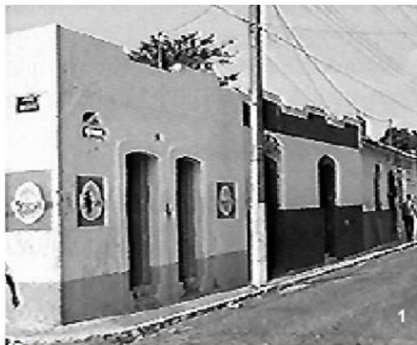
Figura 8. Calle 16 de Septiembre #201 Antes del Sismo del 2003.
