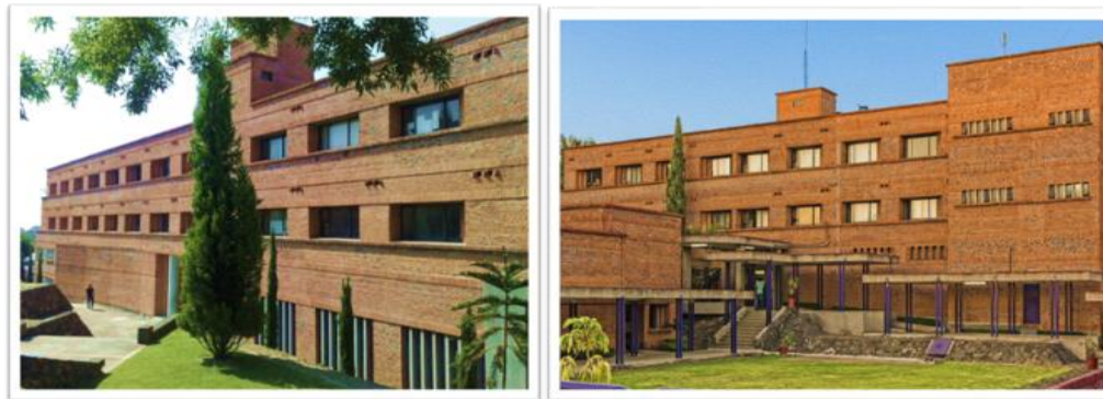
Figura 3.4. Fachadas frontal (orientada al N) y posterior (orientada al Sur) del edificio principal del CIICAp.
