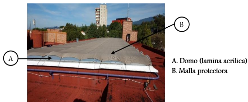
Figura 4.3. Vista panorámica del domo.
