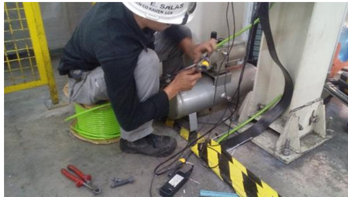
Figura 3-29 Instalación del Booster.
