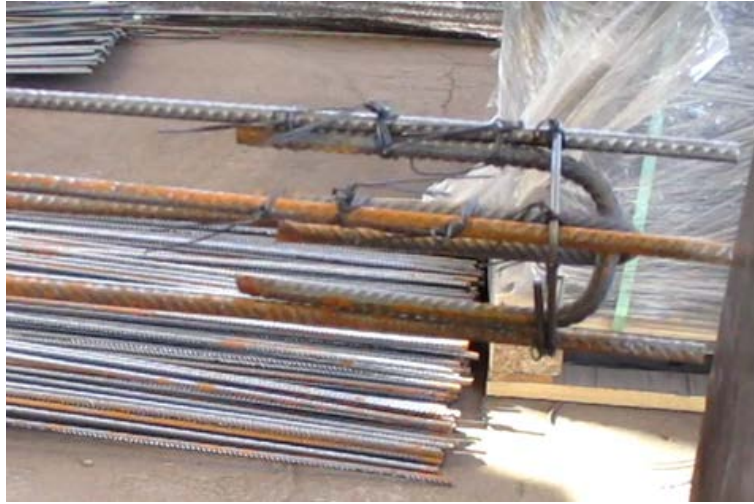
Figura 4.12: Colación de U's en las puntas del armado.
