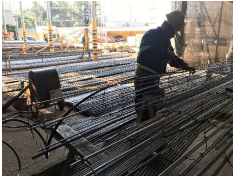
Figura 4.13: Ubicación de poliducto en armado.
