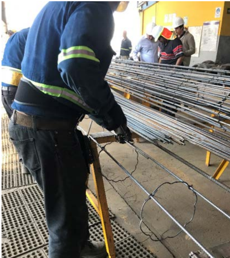
Figura 4.11: Fabricación del armado.
