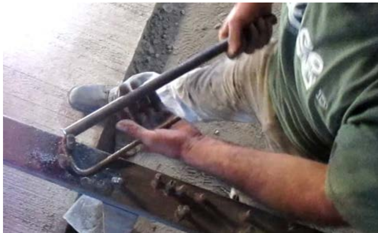
Figura 4.10: Doblado de varilla en forma de “U” con ayuda de las referencias de la mesa de doblado.
