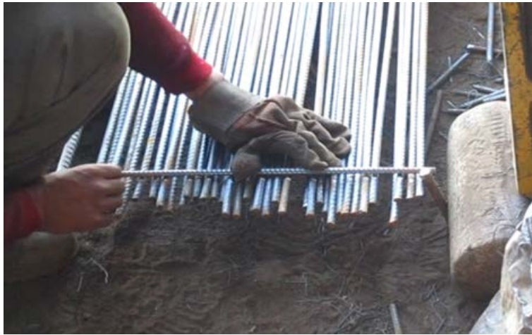
Figura 4.3: Corte de varillas.
