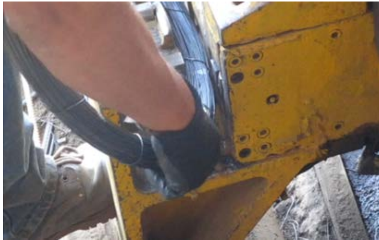
Figura 4.5: Cortado de alambre con una guillotina.
