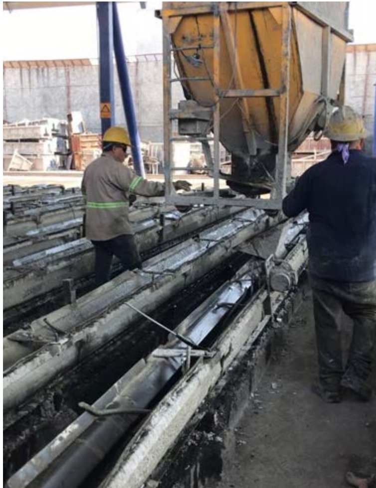
Figura 4.18: Colado de postes con contenedor de concreto móvil.
