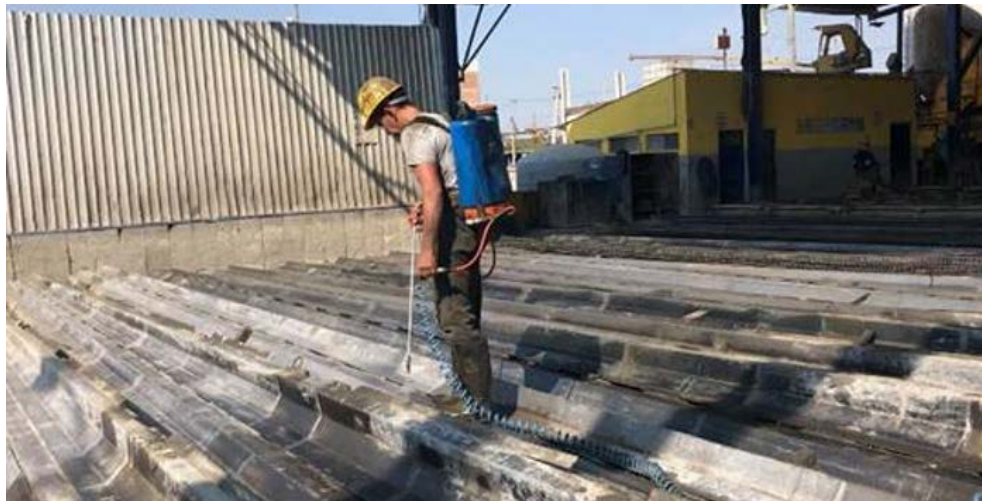
Figura 4.16: Aplicación de desmoldante en moldes para poste.
