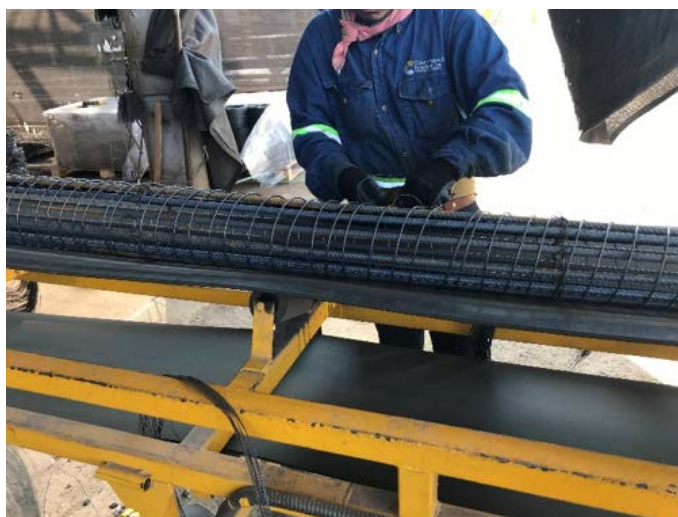
Figura 4.15: Tejido del espiral de zunchado con alambre recocado.
