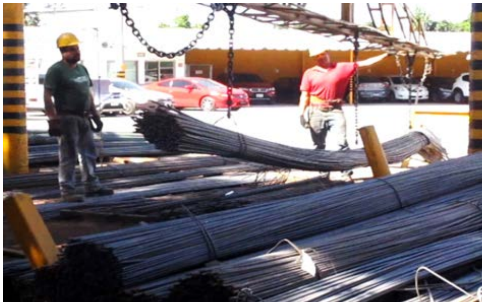
Figura 4.2: Traslado de la varilla a la zona de corte.
