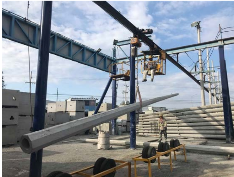
Figura 4.20: Traslado de poste terminado a estibas.
