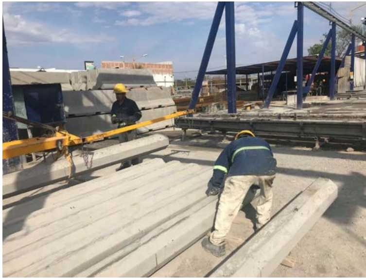
Figura 4.19: Pulido de poste de concreto.
