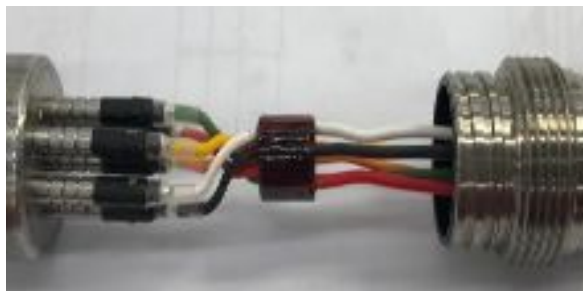
Figura 5. Acomodo de cables de acuerdo a Hook Up.
