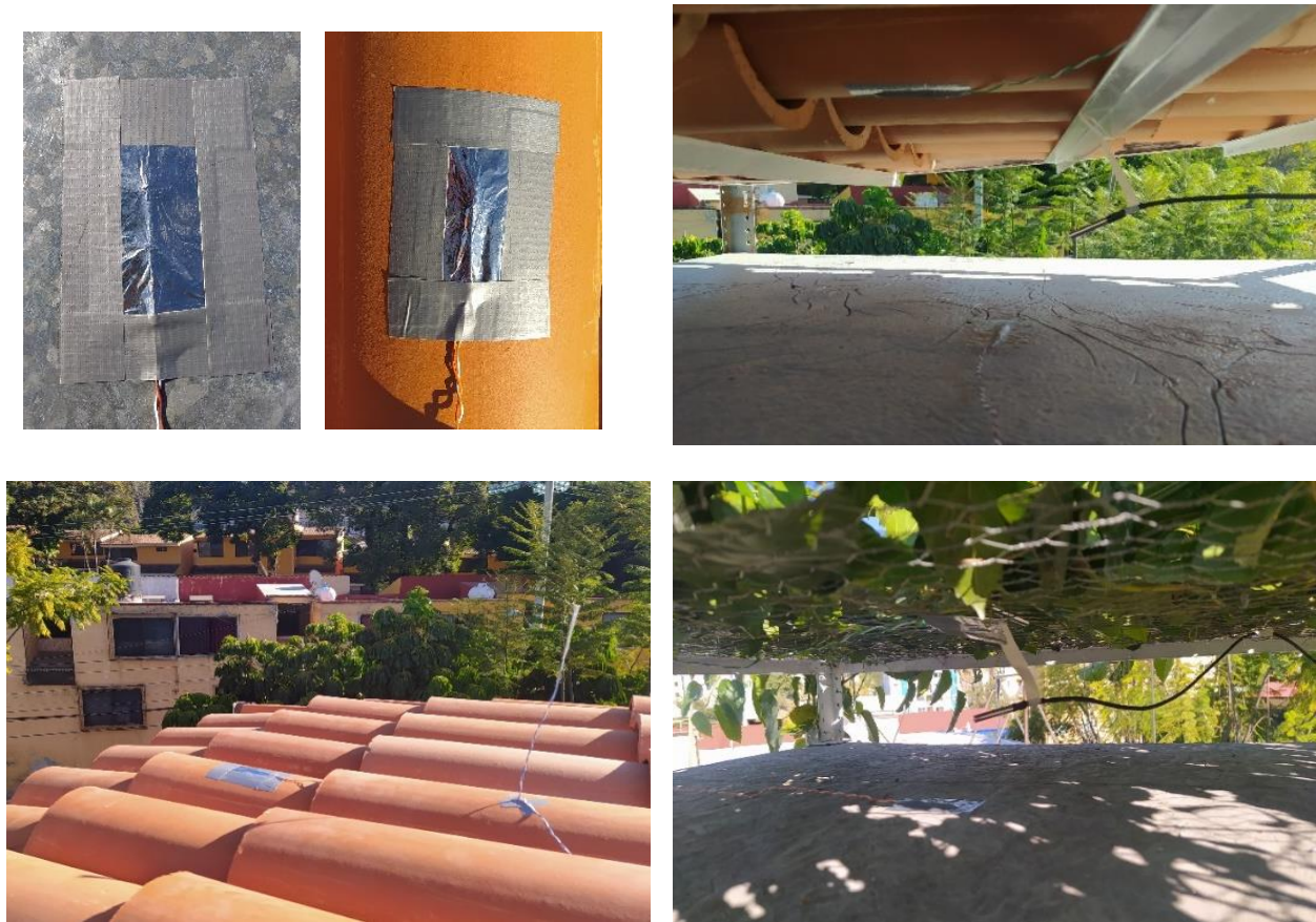
Figura 3.31 Colocación de sensores en los diferentes techos.
