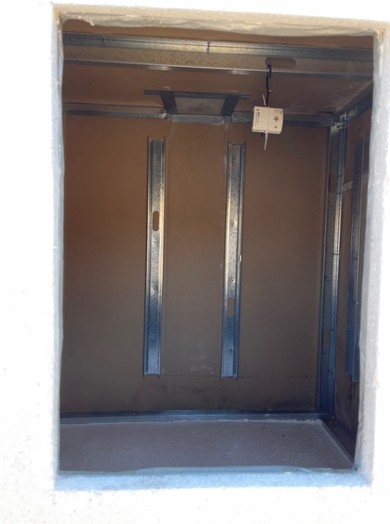
Imagen 9.- Planta y vista del interior. Instalación del HOBO U12-012 al interior del módulo testigo. fuente: elaboración propia.
