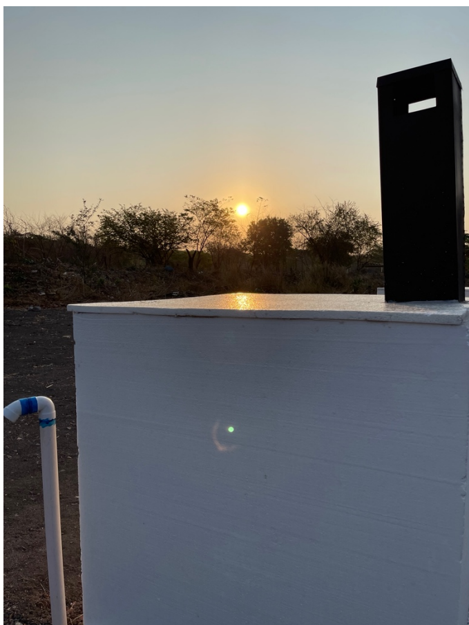
Imagen 14.- Vista del exterior a detalle del tubo subterráneo y chimenea solar abiertos, configuración 4, fuente: elaboración propia.
