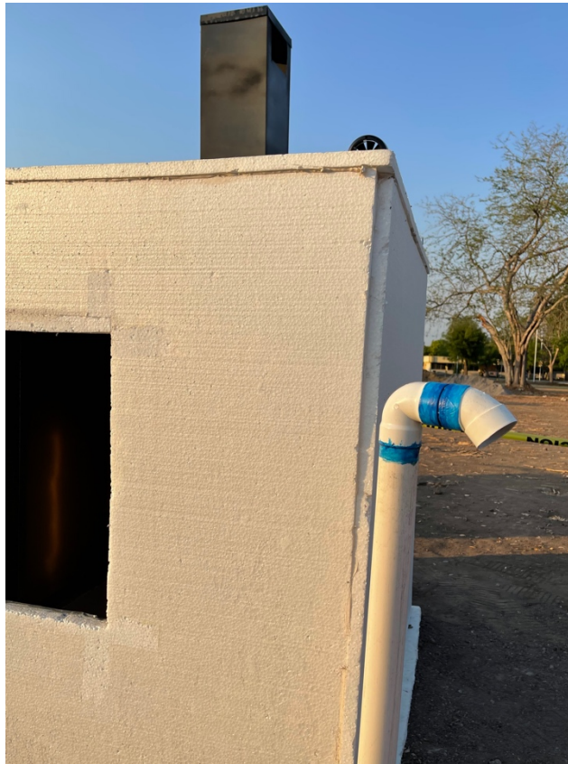
Imagen 12.- Vista del exterior a detalle del tubo subterráneo abierto, configuración 2, fuente: elaboración propia.
