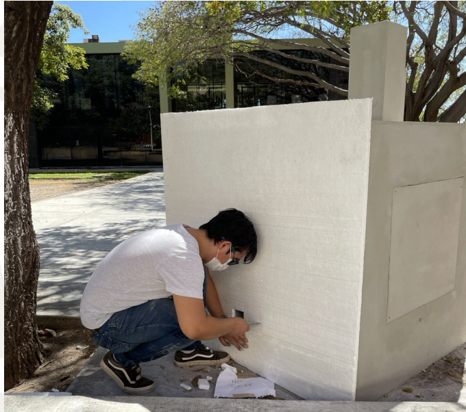
Imagen 18.- Aplicación de lámina aislante, Fuente: Propia.
