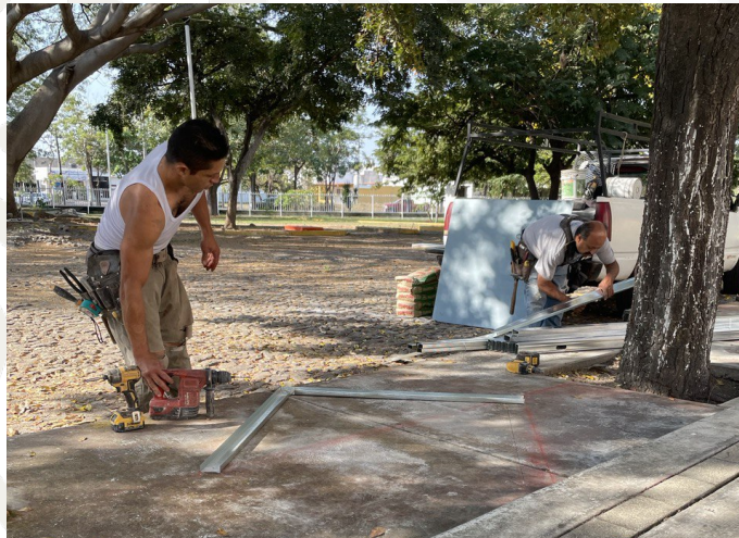
Imagen 8.- Proceso de armado de perfilaría de aluminio, Fuente: Propia.
