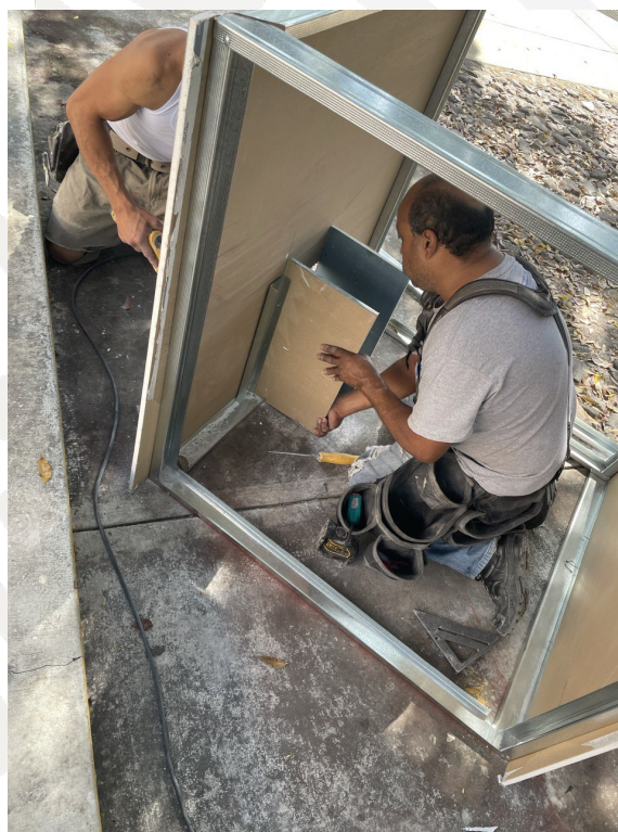
Imagen 12.- proceso de fabricación chimenea, Fuente: Propia.
