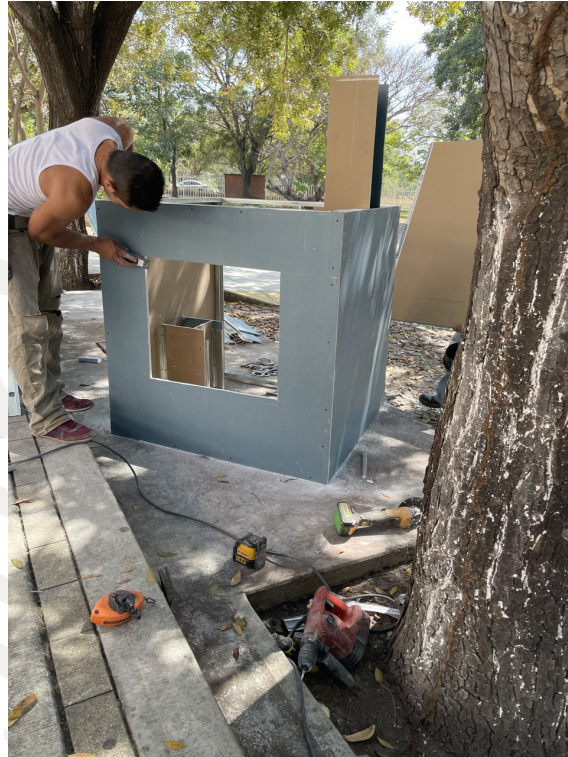
Imagen 14.- Fabricación de puerta de acceso removible, Fuente: Propia.
