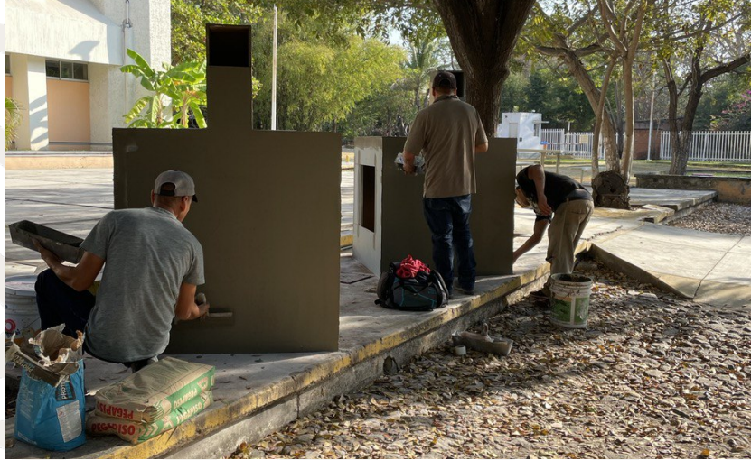
Imagen 16.- Aplanado de módulos con mezcla de pega piso con arena, Fuente: Propia.
