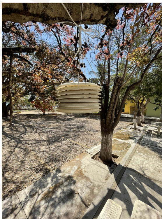
Imagen 26.- Torre protectora de sensor, Fuente: Propia.
