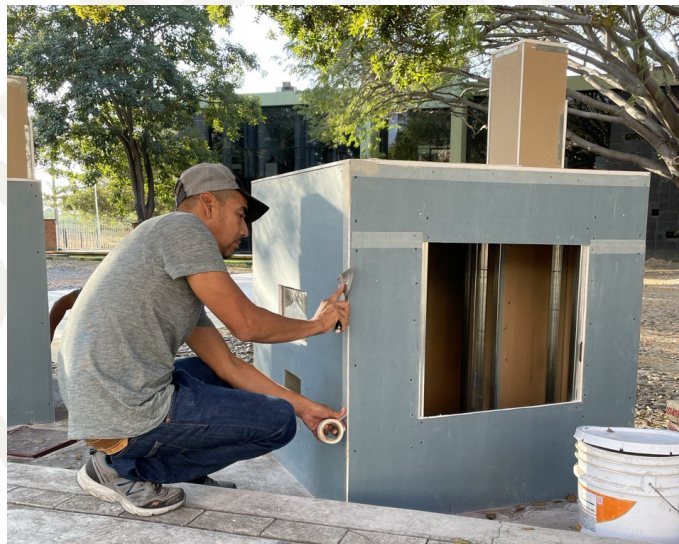
Imagen 15.- Sellado de uniones de paneles, Fuente: Propia.
