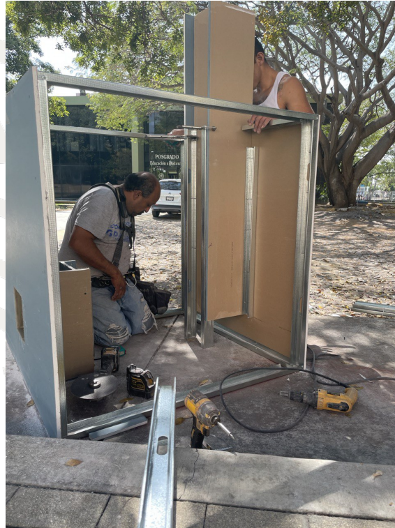
Imagen 13.- Fabricación de torre de viento, Fuente: Propia.
