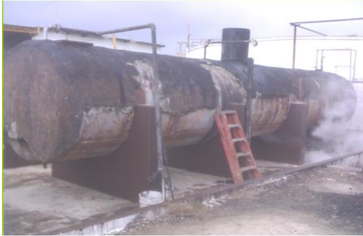
Figura 3.8 Tanque Receptor de Combustóleo
