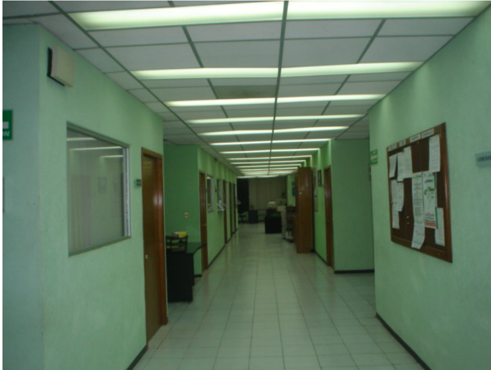
Figura 4.7.2 Pasillo del 1er piso de las oficinas generales lámparas de 2 x 75 W.
