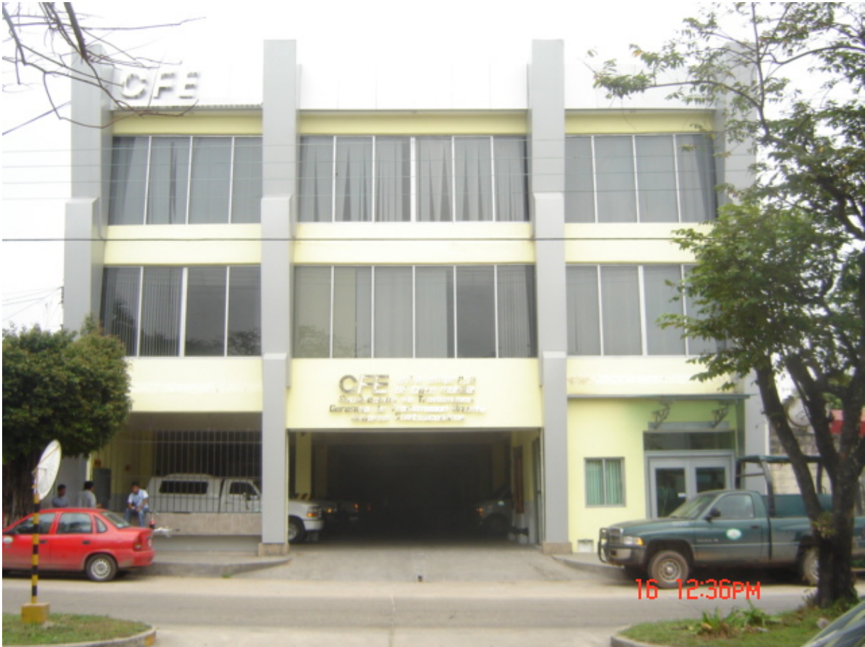
Figura 5.2.1 Edificio de las oficinas generales de la Subárea de Transmisión Coatzacoalcos.
