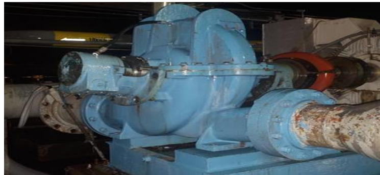
Figura 15 Fuga de Solución por Válvula de Succión
