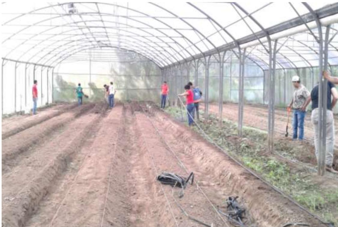
Figura 6. Instalación del sistema de riego por goteo.
