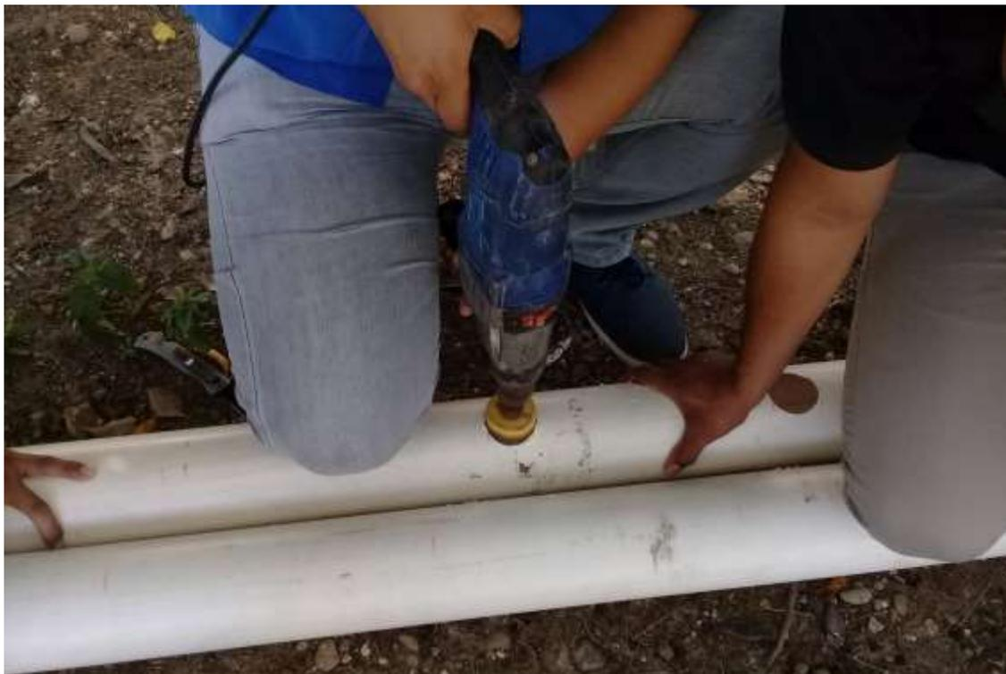
Figura 10. Perforación del tubo PVC para el sistema de hidroponia.
