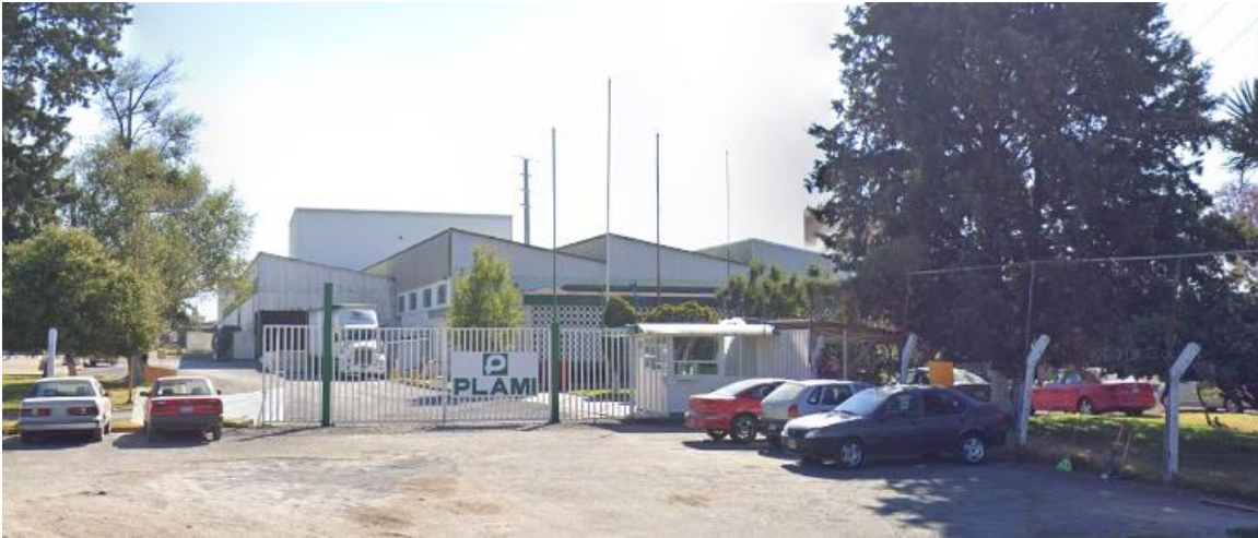
Figura 4 Instalaciones de PLAMI
