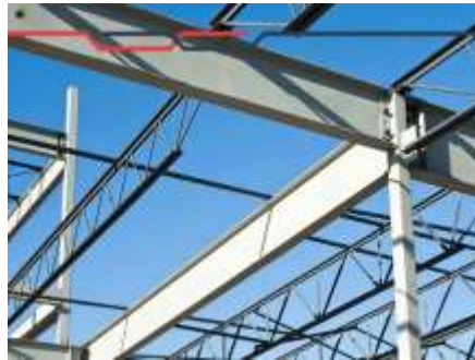
Figura 6. Estructura con vigas.
