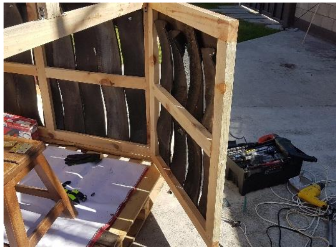
Figura 65. Colocación de puerta (Ortega, 2019).
