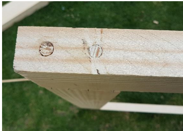
Figura 57. Clavacotes hundidos para unión de estructura (Ortega, 2019).
