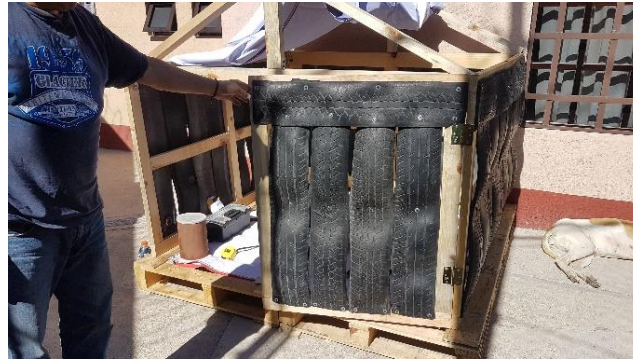
Figura 66. Estructura completa de primer módulo (Ortega, 2019).
