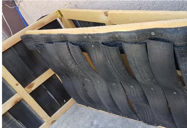
Figura 62. Muros de primer módulo (Ortega, 2019).
