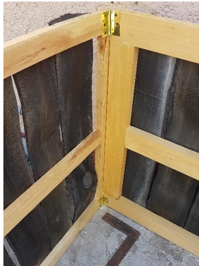
Figura 61. Bisagras en unión de paneles (Ortega, 2019).
