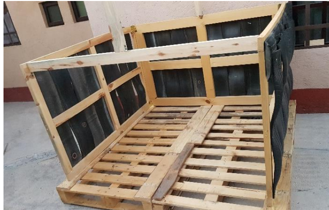
Figura 64. Estructura de muros de primer módulo (Ortega, 2019).
