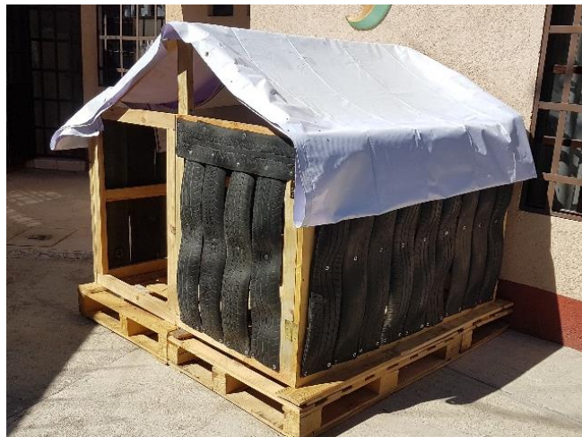
Figura 67. Primer módulo cubierto con lona (Ortega, 2019).
