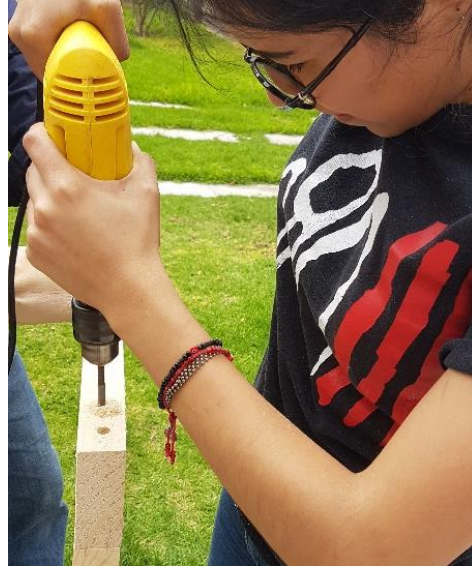
Figura 56. Perforado con taladro para hundimiento de clavacotes (Ortega, 2019).
