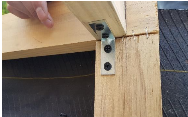
Figura 63. Colocación de barrote de soporte con uso de escuadra y tornillos (Ortega, 2019).
