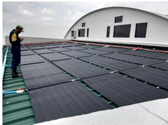
Fig. 35 Calentadores solares para alberca.
