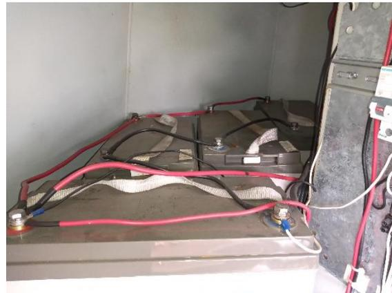
Fig. 25 Baterías de descarga profunda del Árbol de paneles solares
