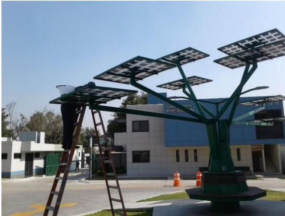
Fig. 18 Limpieza de la superficie frontal de los módulos fotovoltaicos.
