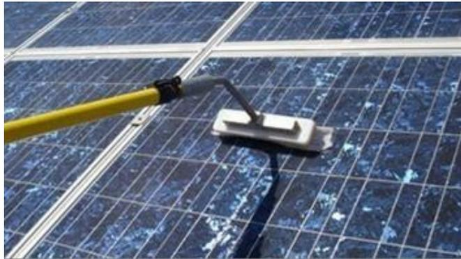
Fig. 10. Limpieza de paneles.
