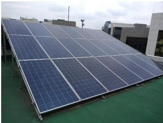
Fig. 28 Paneles solares de la instalación fotovoltaica autónoma.
