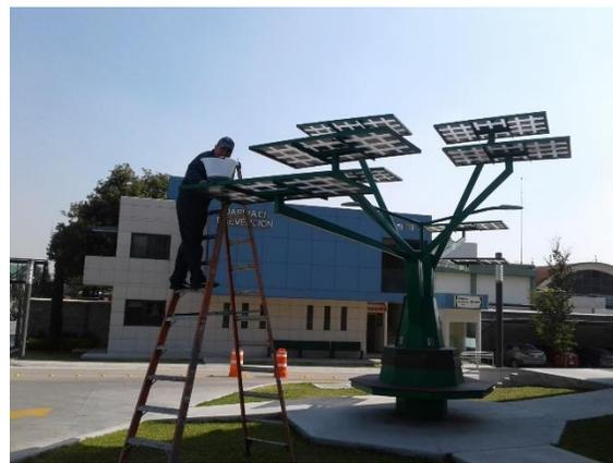
Fig. 19 Limpieza de la estructura de la instalación fotovoltaica.
