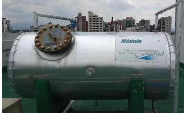
Fig. 33 Termotanque de la instalación de calentamiento de agua sanitaria.
