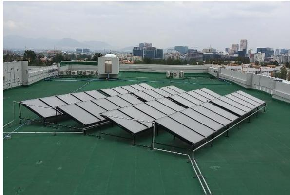
Fig. 31 Instalación de calentadores solares para dormitorios.
