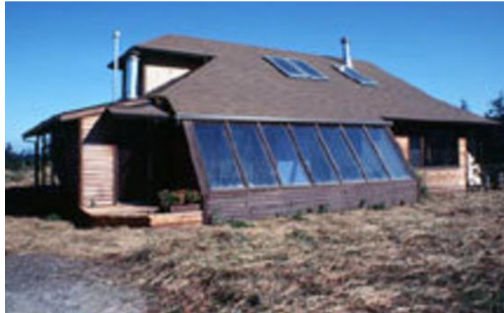
ILUSTRACIÓN 3. EDIFICIO SOLAR PASIVO
