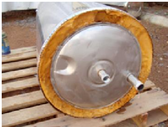
ILUSTRACIÓN 26. CORTE TRANSVERSAL DE UN TERMOTANQUE
