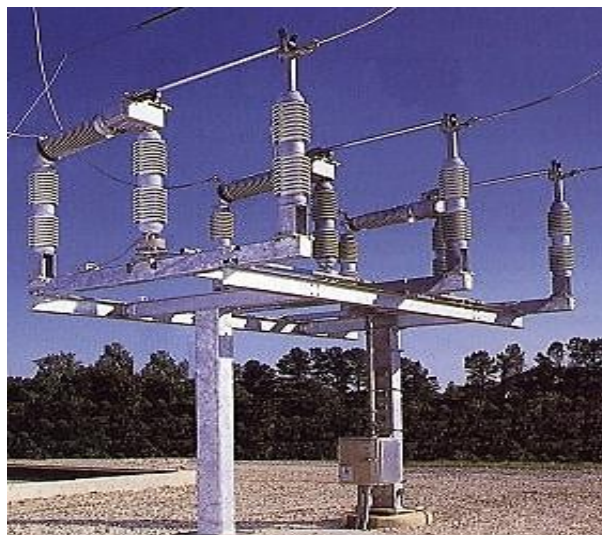
Figura 2.23.- Cuchillas desconectoras para subestaciones.
