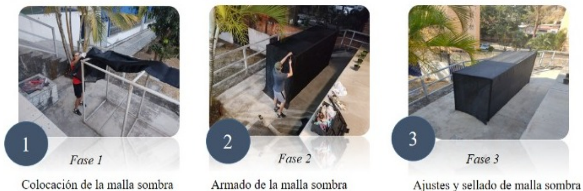
Figura 17. Armado del invernadero
